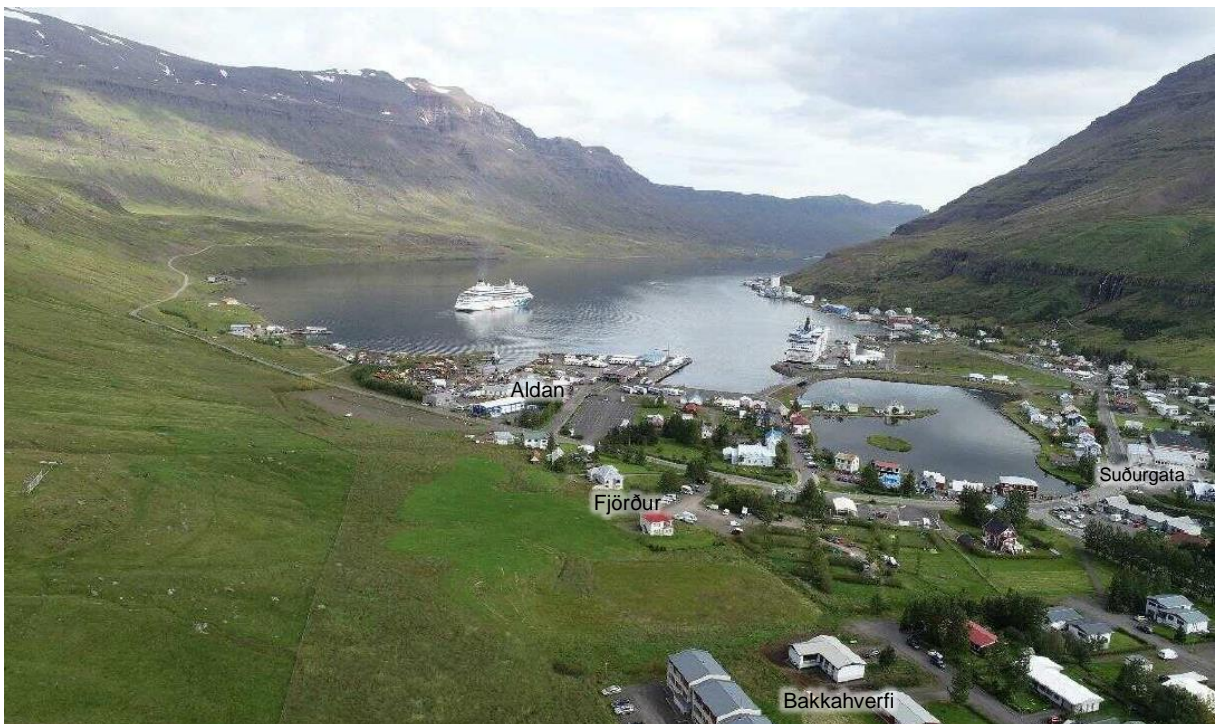
Mynd 19.3 Séð yfir framkvæmdarsvæði Fjarðargarðs og Öldugarðs. Horft í norður, út eftir firðinum. Mynd: Byggðasafn Skagfirðinga.
