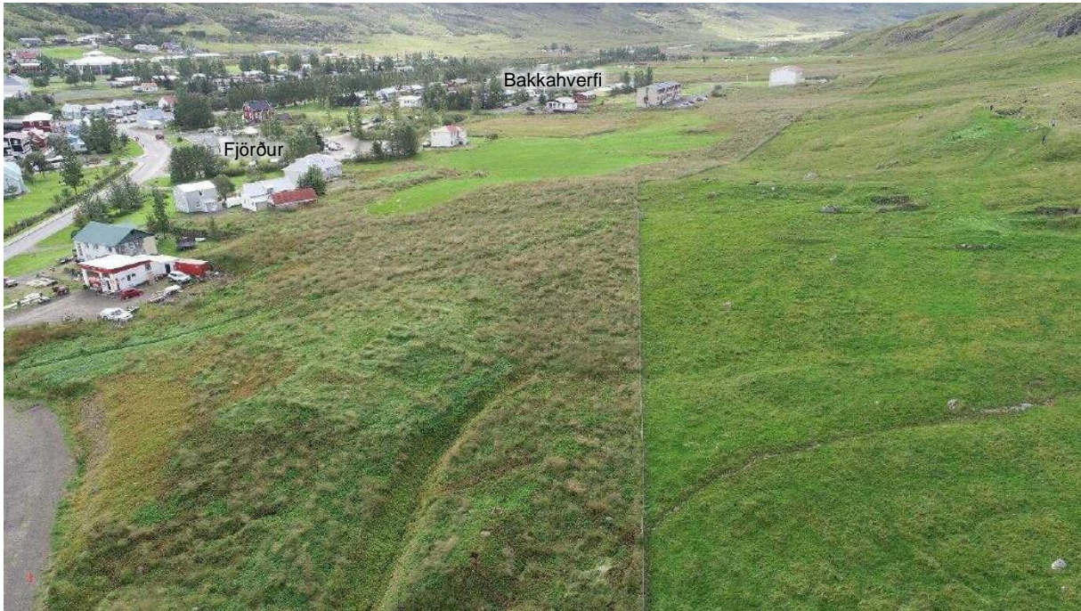
Mynd 19.4 Séð yfir framkvæmdarsvæði Fjarðargarðs og Bakkagarðs, horft í suður. Mynd: Byggðasafn Skagfirðinga.
